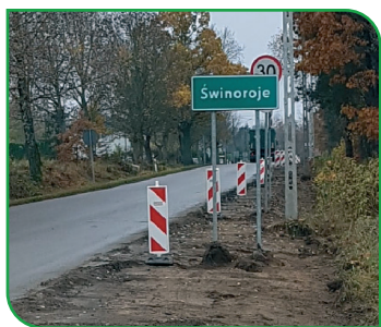
Przed rozpoczęciem robót drogowych
